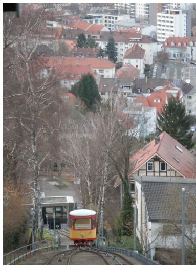
Turmbergbahn mit Abt'scher Weiche, Wagen, Talstation. Dahinter zu erahnen die Bergbahnstraße mit Freihaltetrasse zur Verlängerung; Fotos: Heiko Jacobs
