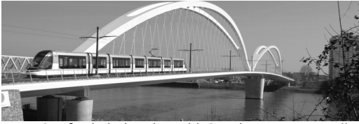
Neue Straßenbahnbrücke Kehl-Strasbourg; F.: U. Müller
