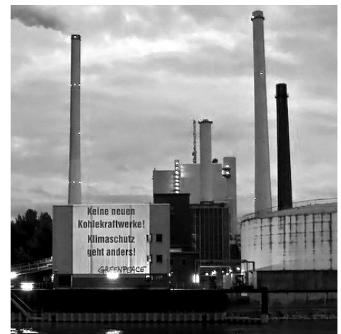
Neben dem „Aktionsbündnis Saubere Luft Region Karlsruhe“ protestiert auch Greenpeace mit Aktionen gegen das geplante Kohlekraftwerk, hier mit der Projektion eines Textes an die Wand des bestehenden Kraftwerkes. Foto: Dr. Morlock-Fien
