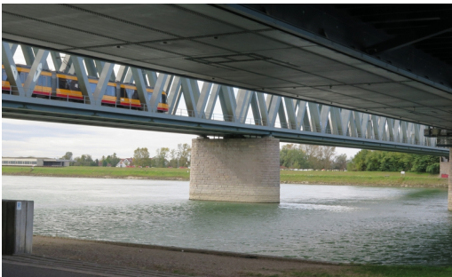
Bahnbrücke neben der 1. Autobrücke; Foto: Uwe Haack
