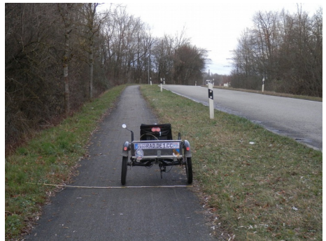
Radweg Raffinerie: Zu schmal für Begegnungen, ab Kurve geht's links abwärts zur Unterführung; Rad 90 cm; Fotos und Grafiken: Heiko Jacobs
