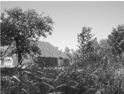
Das auf drei Seiten vom bestehenden Naturschutzgebiet (NSG) „Fritschlach“ umgebene Birkenhofgelände ist aufgrund seiner hochwassergefährdeten Lage in der Federbachaue nicht zur Bebauung geeignet. Das aufkommende Schilf zeigt deutlich den permanent sehr geringen Grundwasserflurabstand an. Die BUZO fordert die Arrondierung des NSG Foto: Johannes Meister
