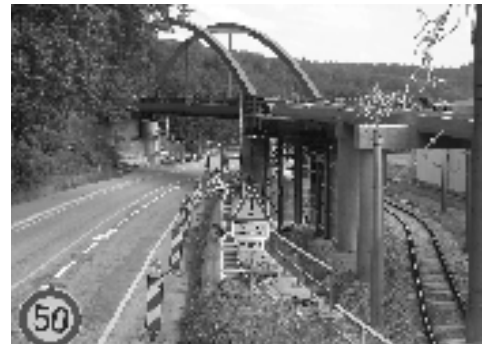
Das Projekt Busenbach bleibt vorerst unvollendet, da für die Verlegung der Strecke noch das Geld fehlt. Foto: Johannes Honne
