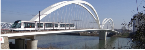
Neue Straßenbahnbrücke Kehl–Strasbourg; F.: U. Müller
